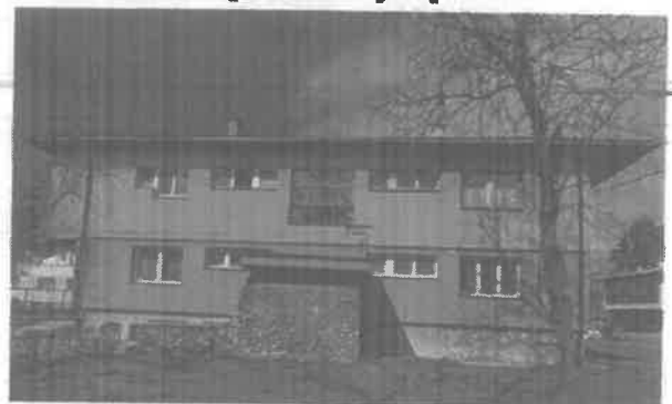
Radovi na implementaciji mjera EE
