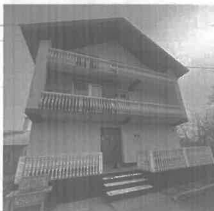
Radovi na implementaciji mjera EE
