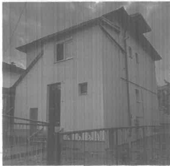
Radovi na implementaciji mjera EE
