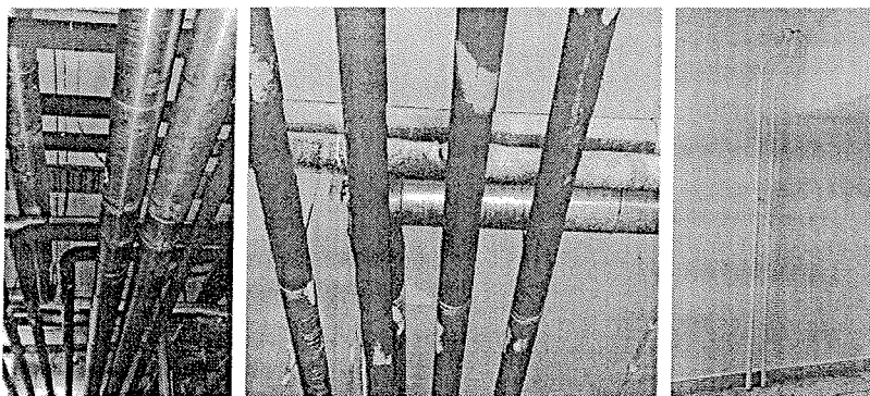
Slika 4: Dio cijevne mreže u toplotnoj podstanci (lijevo i u sredini) i dio cijevne mreže u objektu (desno)
