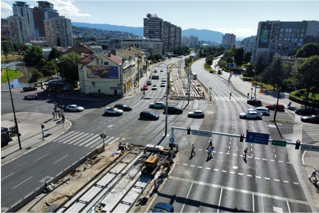
Raskrsnica u toku rekonstrukcije
